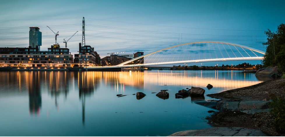
Isoisänsilta Bridge in Helsinki, Finland. Photo: Unsplash / Taipo Haaja
