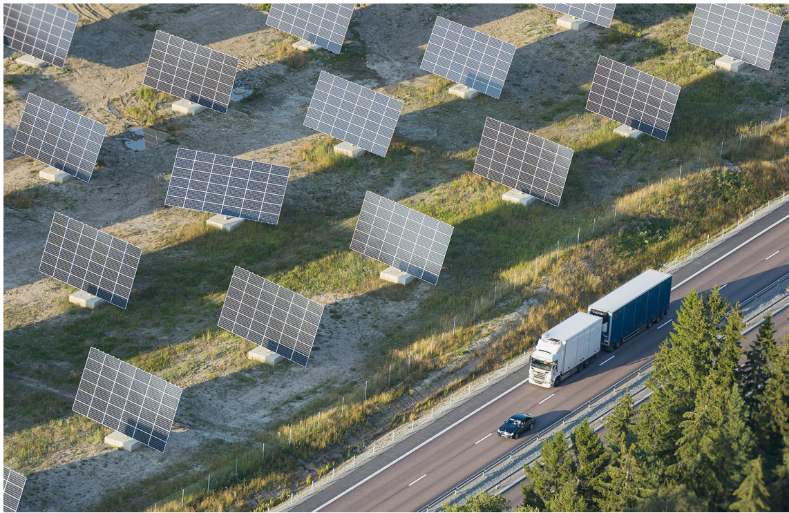
Solar panels in Västerås Sweden.
