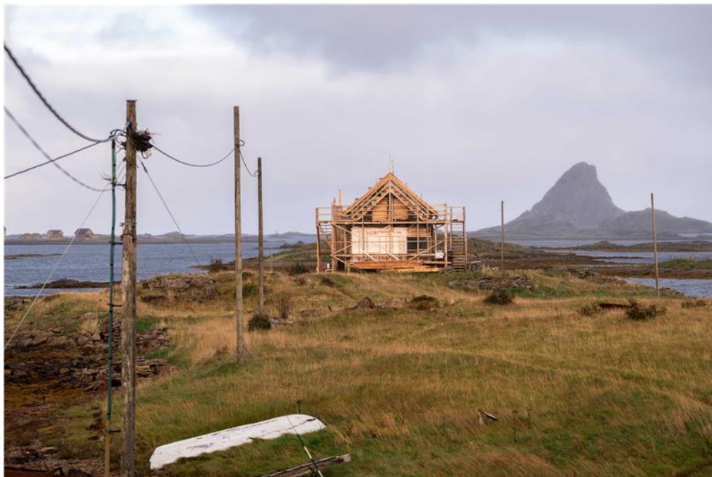
Istandsetting av eldre hus, Kårøya Røst. Foto: Hedvig Idås
